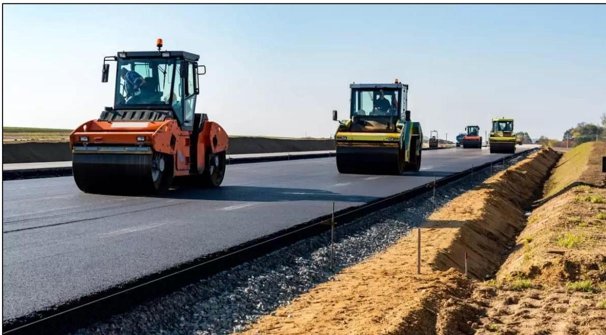
Le dimensionnement des chaussées routières est une étape clé dans la conception et la réalisation des infrastructures de transport. Il consiste à définir la structure de la chaussée — nature et épaisseur des différentes couches de manière à assurer une bonne répartition des charges de trafic, une résistance suffisante aux agressions climatiques et une durabilité satisfaisante sur toute la durée de service de l'ouvrage.
